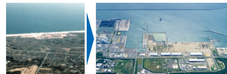
着工時・1989年(左)と現在(右)の常陸那珂港区。着々と整備が進む。
