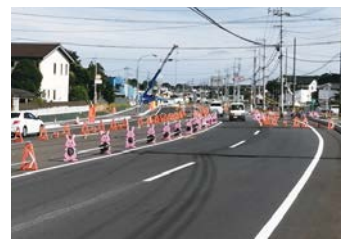
国道118号線・バードライン4車線化 (那珂市瓜連地区)
