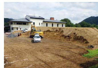
大子町衛生センター復旧事業 (大子町南田気)
