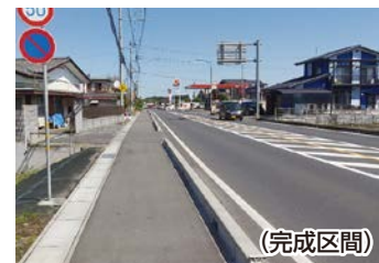
国道118号線歩道安全対策 (那珂市豊喰地区) (完成区間)
