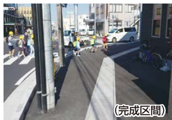
国道293号線歩道安全対策 (常陸大宮市下町) (完成区間)
