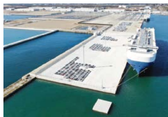
茨城港常陸那珂港区の岸壁2パース目を完成形300mで整備 (中央ふ頭地区)
