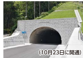
国道461号北沢トンネル整備 (常陸太田市折橋町) (10月23日に開通)
