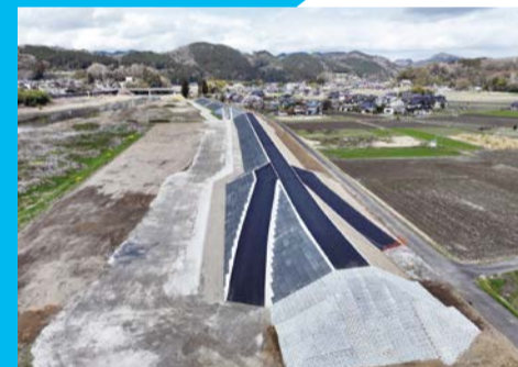
久慈川堤防整備(西野内)
