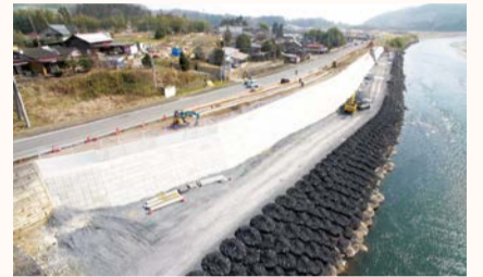
常陸大宮市野口 堤防整備
