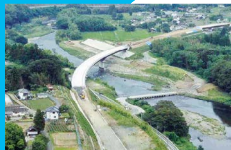
国道118号袋田バイパス 北田気大橋(大子町北田気)
