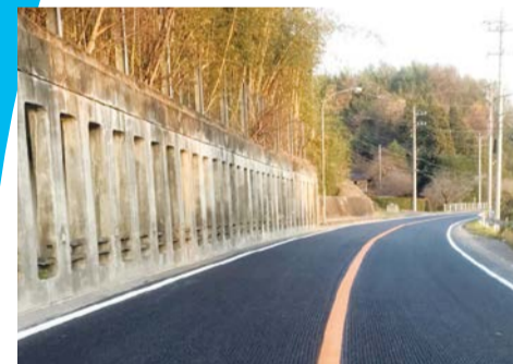
国道123号舗装修繕工事(金井)
