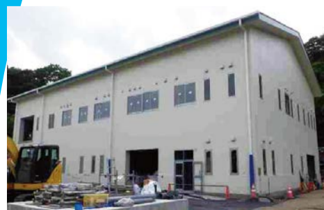
大子町衛生センター処理施設 地上部躯体完成(大子町南田気)
