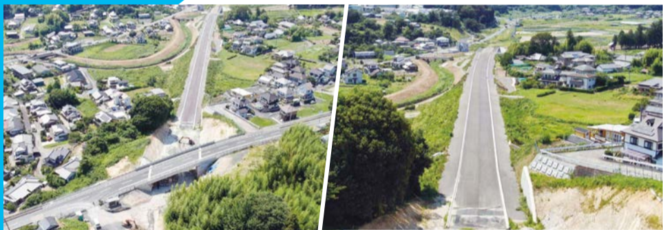
国道293号常陸太田東バイパス整備(常陸太田市増井町)
