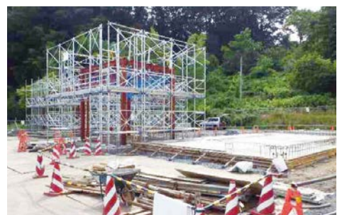
大子町衛生センター汚泥資源化施設 基礎コンクリート工事(大子町南田気)
