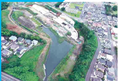
中丸川調整池整備(ひたちなか市中根、長堀町)
