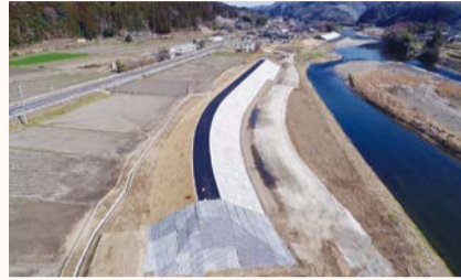
常陸大宮市舟生 堤防整備
