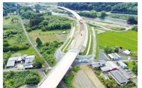
国道118号袋田バイパス 南田気跨線橋(大子町南田気)
