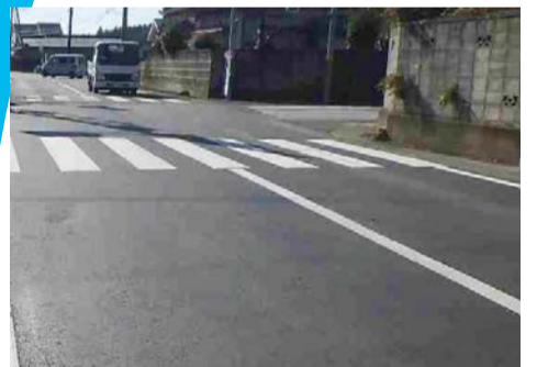
常陸那珂港山方線舗装修繕工事(南酒出)
