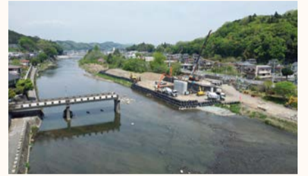
大子町 松沼橋新設下部工事
