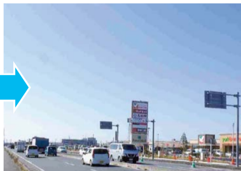
施工後(常陸太田市金井町)
