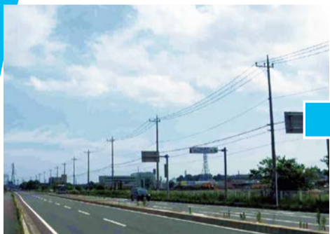
国道349号(金井町工区)電線共同溝事業
