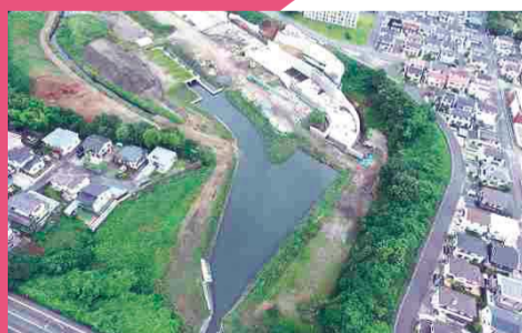
中丸川調整池整備(ひたちなか市中根、長堀町)
