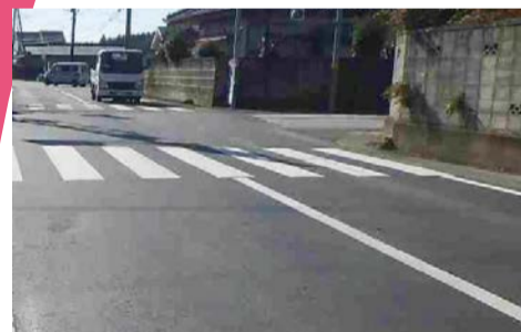
常陸那珂港山方線舗装修繕工事(那珂市南酒出)
