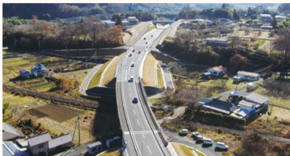
国道118号袋田バイパス南田気跨線橋(大子町南田気)
