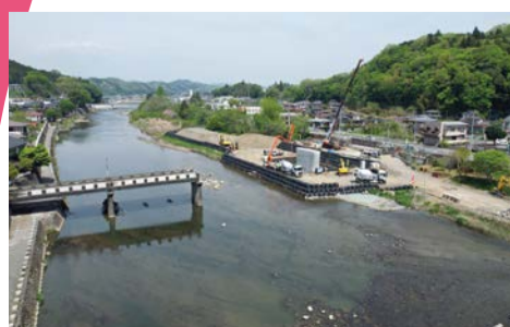
大子町 松沼橋新設下部工事(久慈川)
