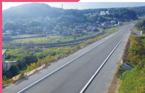
国道293号道路改良工事(常陸太田市増井町)
