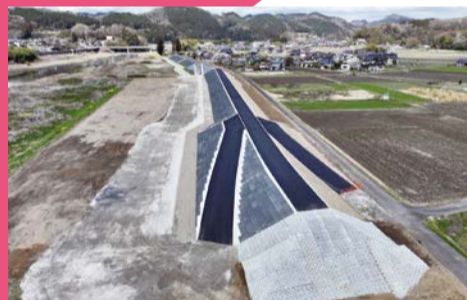
久慈川堤防整備(常陸大宮市西野内)
