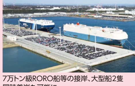
7万トン級RORO船等の接岸、大型船2隻同時着岸も可能に
