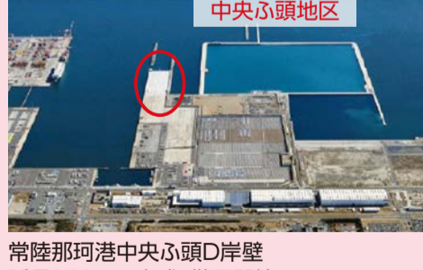
常陸那珂港中央ふ頭D岸壁延長300mで完成・供用開始
