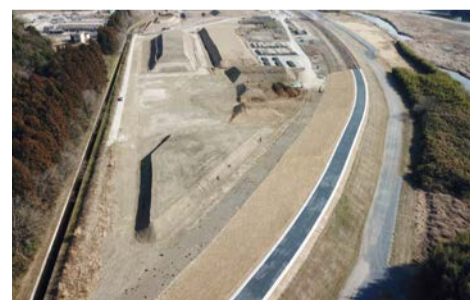
常陸大宮市大場遊水地 堤防整備(那珂川)
