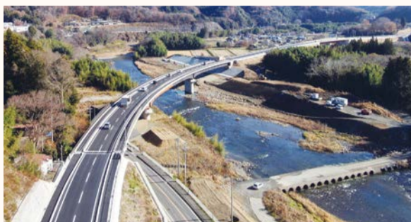
国道118号袋田バイパス北田気大橋(大子町北田気)
