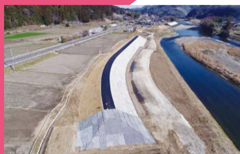
常陸大宮市舟生 堤防整備(久慈川)
