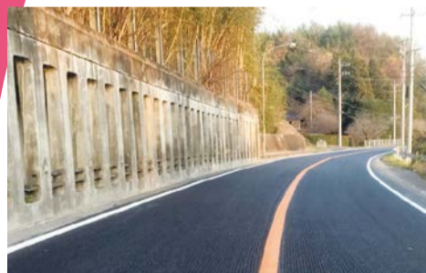
国道123号舗装修繕工事(常陸大宮市金井)
